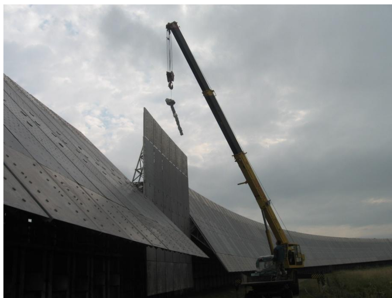
Рис.2. Процесс разборки винтов для выполнения регламентных работ
