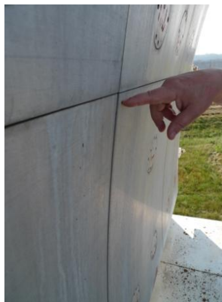
Рис. 7 Щели на стыках щитов (б)
