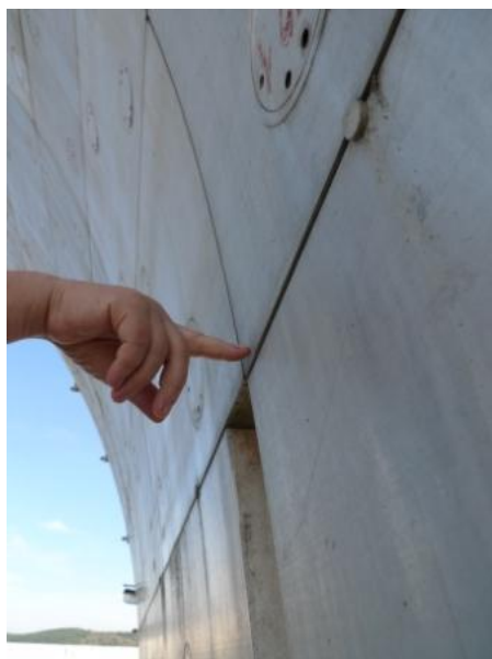
Рис. 6 Щели на стыках щитов (а)
